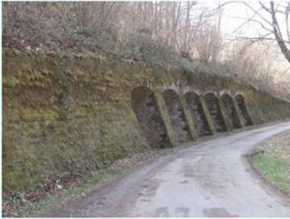
Soutènement de la ligne Aillevillers-Plombières
