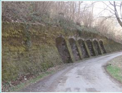
Soutènement de la ligne Aillevillers-Plombières
